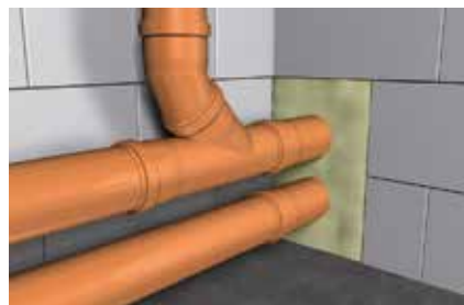
Riempimento di attraversamenti di tubazioni
