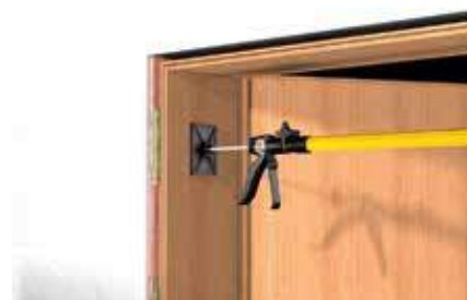
Schiumatura di telai di porte
