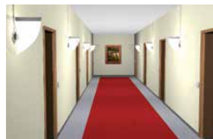
Installazione di plafoniere in serie
