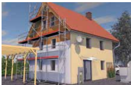
Fissaggio di pannelli di isolamento
