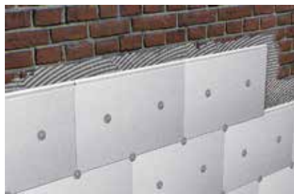
Pannelli in schiuma rigida di polistirene su mattoni pieni
