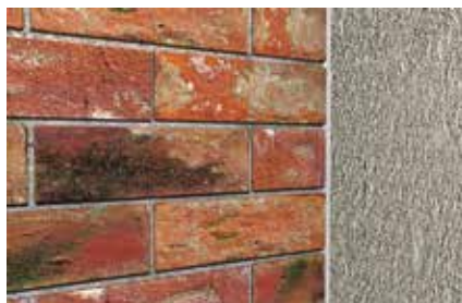
Giunti in muratura
