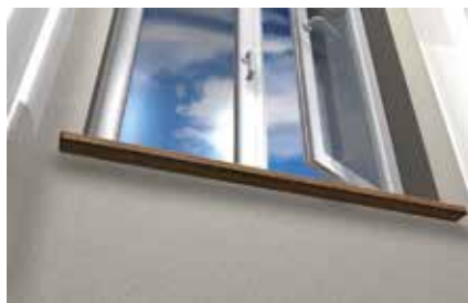
Sigillatura di serramenti
