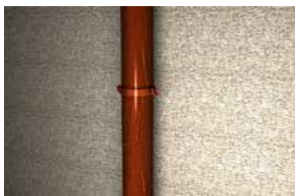
Fissaggio di canali di gronda
