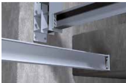
Travature in acciaio
