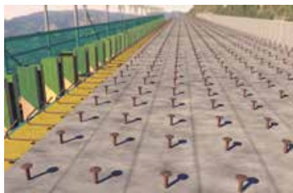
Rinforzo di solette da ponte
