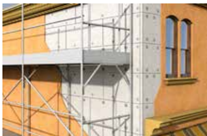
Fissaggio di pannelli isolanti
