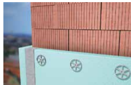
Riempimento di cavità tra pannelli isolanti
