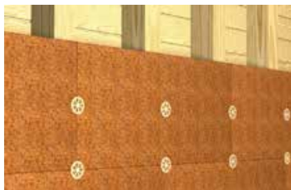
Fissaggio di pannelli in fibra soffice su legno massiccio
