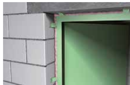
Schiumatura di telai di porte in acciaio
