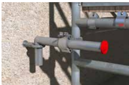
Fissaggio al ponteggio
