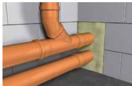
Riempimento di attraversamenti di tubazioni
