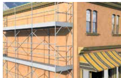
Ponteggi di facciata
