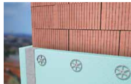
Incollaggio di pannelli isolanti
