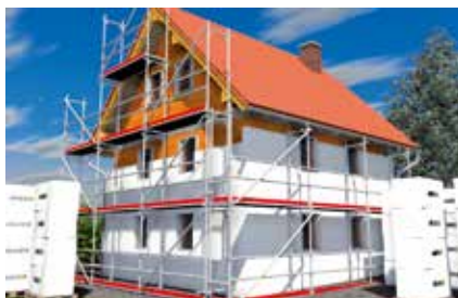
Incollaggio di pannelli isolanti per sistemi ETICS
