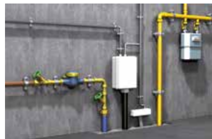
Fissaggio delle condotte
