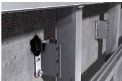
Sigillatura della testa delle viti
