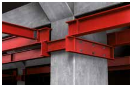
Strutture in acciaio
