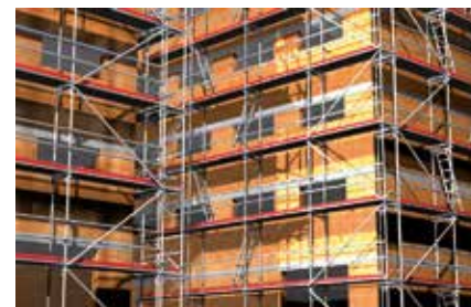
Ponteggio per facciata
