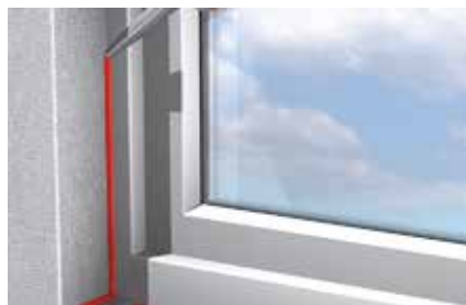
Sigillatura lato esterno di serramenti
