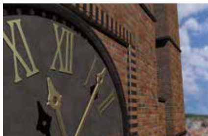
Risanamento murature faccia vista
