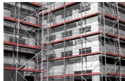
Ponteggio per facciata
