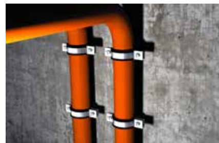
Fissaggio delle condotte in plastica
