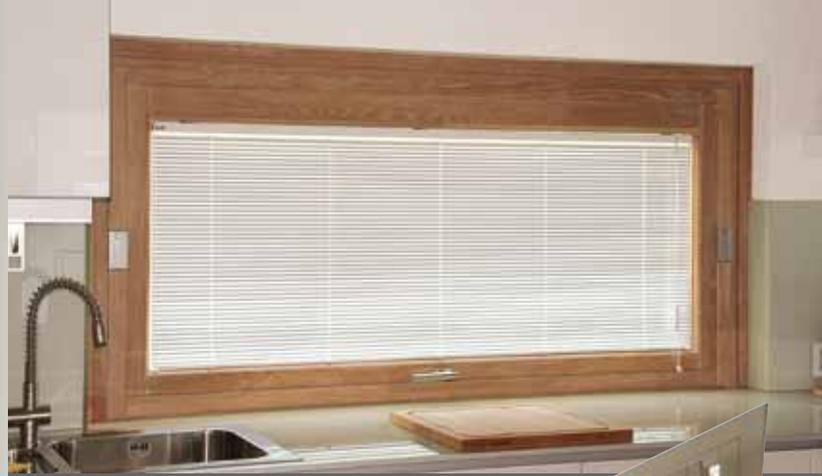
Alcuni esempi di finestre a bilico orizzontale o verticale (realizzabili in tutti i legni e colori). Questo tipo di apertura è ottimale per ottenere ampie vetrate apribili in spazi ristretti, in quanto riserva un ingombro minimo degli spazi interni.
