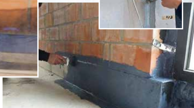
Soudatight LQ - Applicazione a pennello
