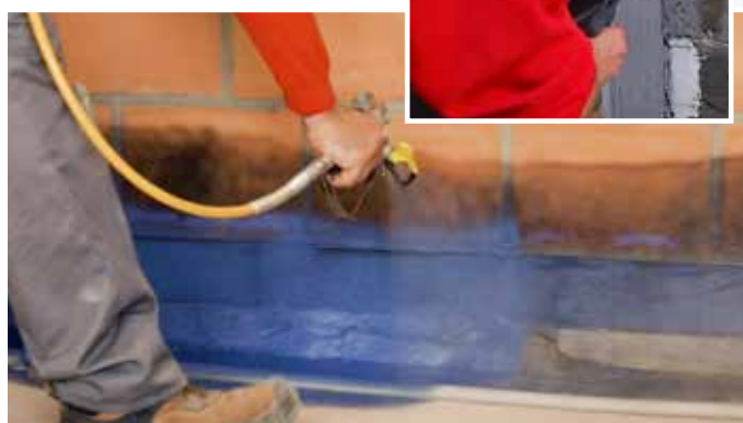
Soudatight SP - Applicazione a spruzzo
