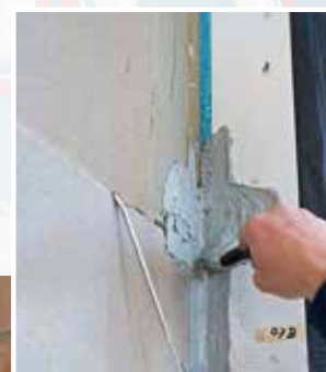
Soudatight Hybrid Applicazione a pennello
