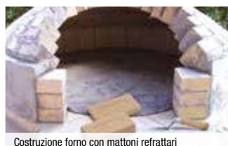
Costruzione forno con mattoni refrattari
