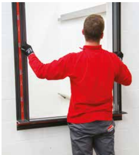
09 Prendere il telaio ed incollarlo al muro muovendolo leggermente su e giù, destra o sinistra
