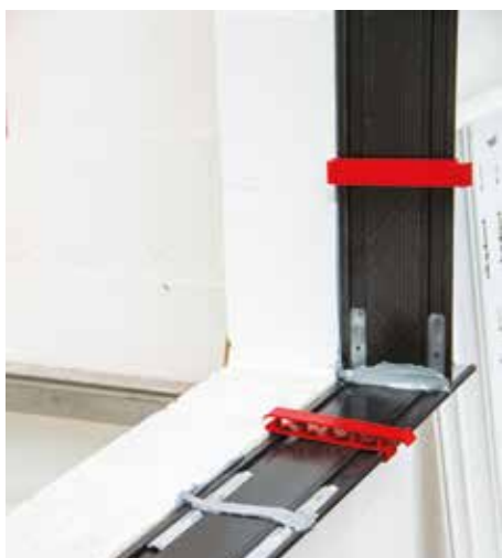
12 Sigillare gli angoli interni e posizionare i clip a molla
