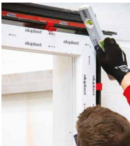
13 Pre-forare la finestra, inserire, mettere in bolla
