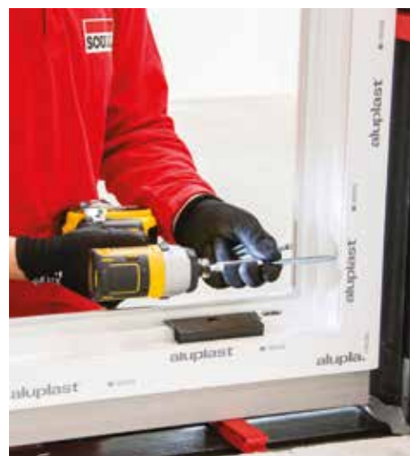
14 Fissare la finestra meccanicamente
