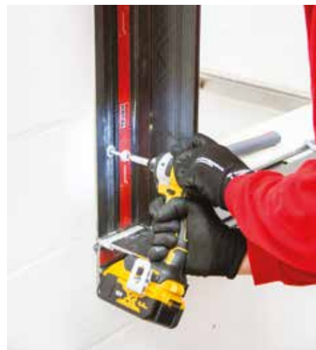
11 Fissare il telaio al muro con i tasselli appropriati
