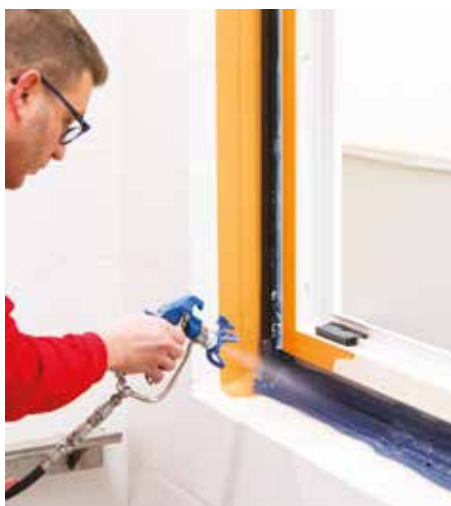
16 Sigillare all'interno con Soudatight LQ/SP
