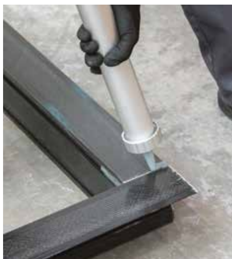
07 Applicare l'adesivo su tutti i giunti di connessione
