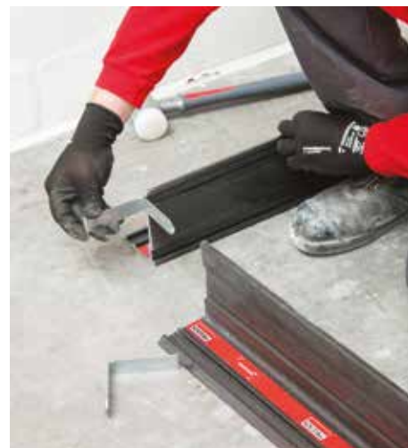
03 Inserire gli angoli di connessione
