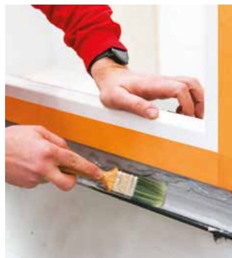
17 Sigillare all'esterno con Soudatight Hybrid
