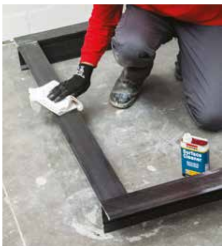
06 Pulire il retro del telaio
