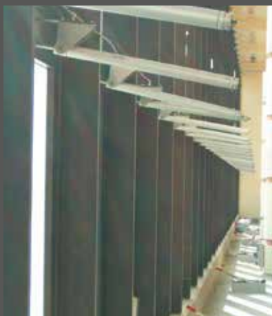
Su serramenti a vasistas esterni con allaccio ad impianto di aria compressa
